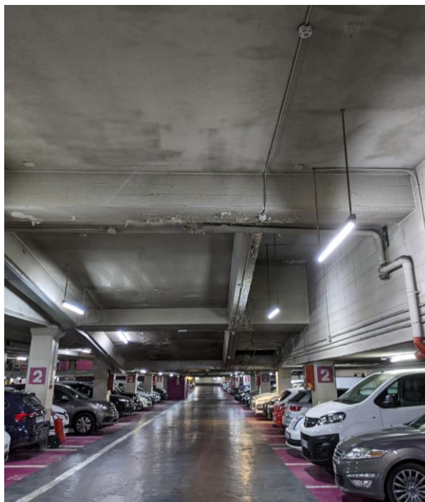
Foto 3. Entramado de vigas apoyo de la rampa de entrada
